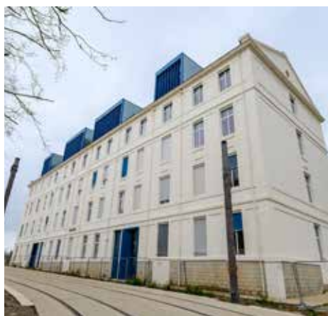
Le quartier de la Cité Créative offre un bel exemple de réhabilitation d'un site existant.
