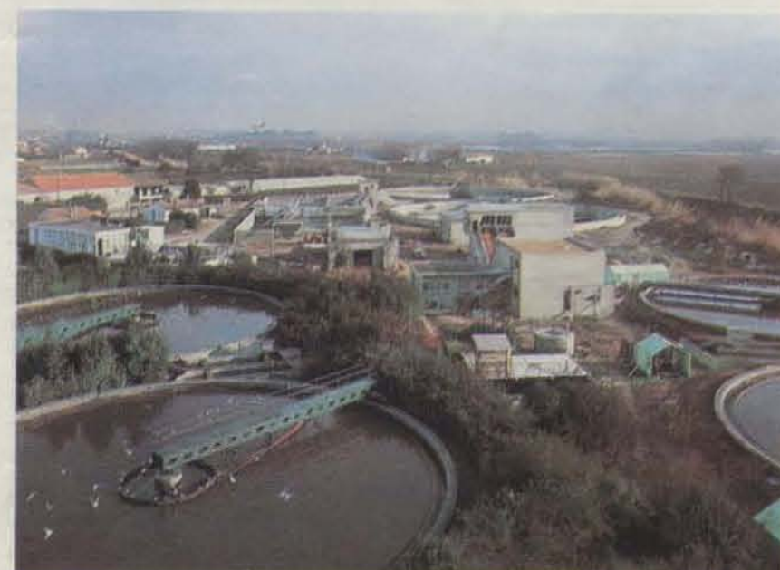
Vue générale. Au premier plan : les 4 décanteurs de la phase physique. Au deuxième plan : la phase biologique, mise en eau des ouvrages.
