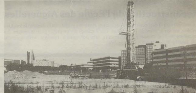
Une Société spécialisée, derrière la Trésorerie Générale, sur le terrain d'Antigone, fore actuellement un puits de plusieurs centaines de mètres de profondeur pour évaluer les possibilités d'existence d'eau chaude en profondeur. En cas de succès, Antigone pourra être largement chauffée par ce procédé révolutionnaire faisant appel aux énergies douces.
