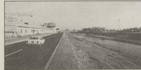
Cette voie sur berge a été réalisée afin d'élargir le réseau de voirie et de décongestionner les carrefours les plus encombrés : longueur 735 m, largeur 7 m (2 voies). La Ville de Montpellier continue sa politique d'aération de la circulation, en détournant les difficultés initiales qui sont celles d'une ville ancienne au maillage urbain extrêmement étroit.
