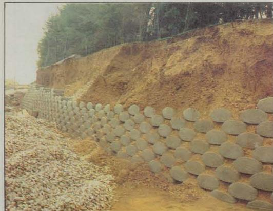
Rue des Bouisses : construction d'un talus à parement de béton qui sera recouvert de végétation.
