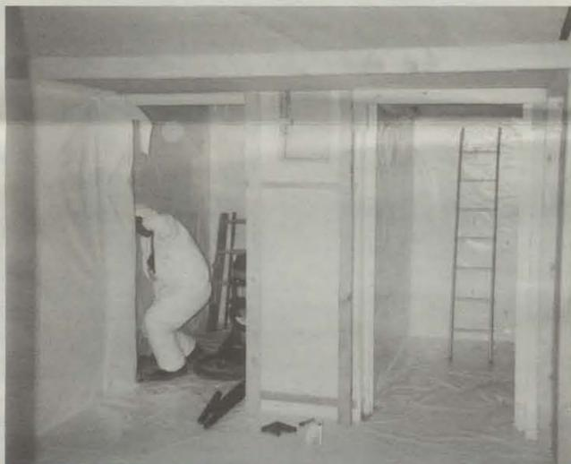
Le déflocage de l'amiante est une opération méticuleuse effectuée par des spécialistes avec le maximum de sécurité
