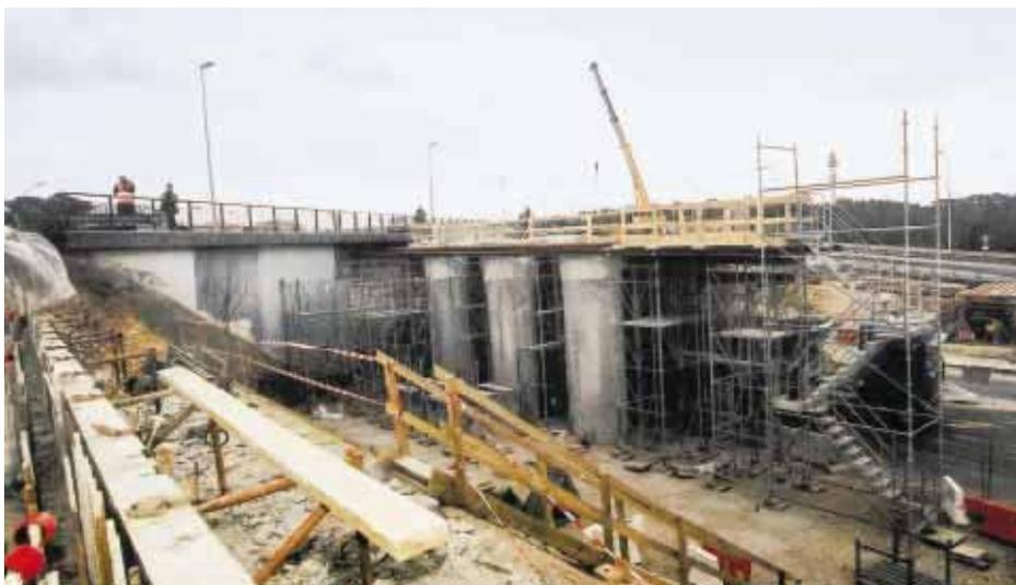
Le carrefour d'échange Spaak nécessite la construction de 4 000 m<sup>2</sup> de murs de soutènement et d'un pont sur la voie d'accès à la Paillade avec pour challenge d'effectuer les travaux sans gêner la circulation automobile.
