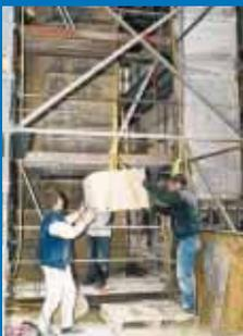
Les nouvelles pierres sont retaillées sur place avant leur mise en place. Parmi les pierres d'origine, une partie est réutilisée en complément pour combler et fixer les parements les moins visibles.
