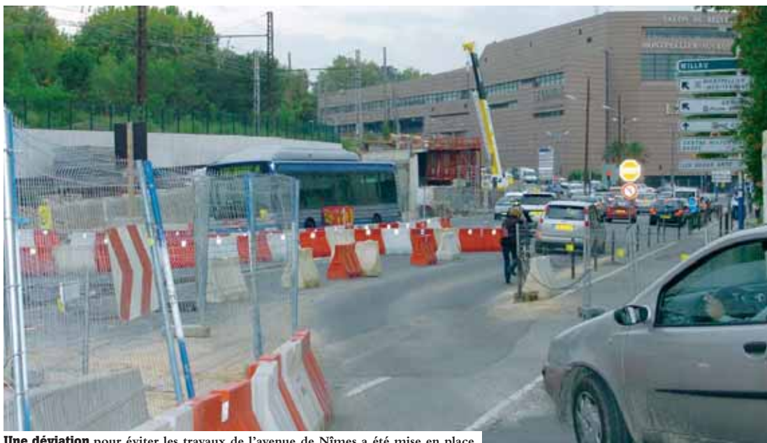
Une déviation pour éviter les travaux de l'avenue de Nîmes a été mise en place.
