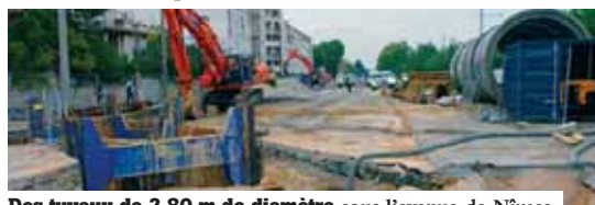
Des tuyaux de 2,80 m de diamètre sous l'avenue de Nîmes.
