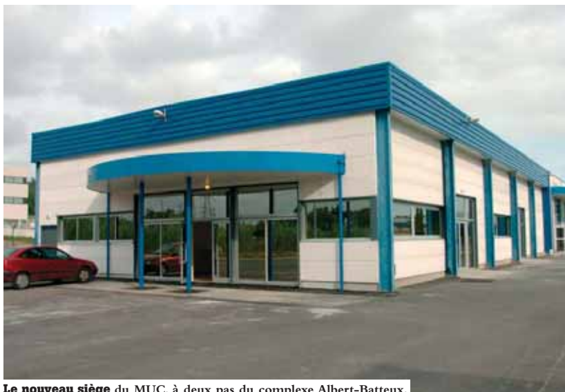
Le nouveau siège du MUC, à deux pas du complexe Albert-Batteux.
