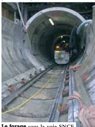
Le forage sous la voie SNCF
