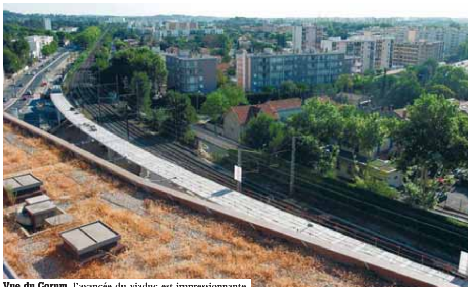
Vue du Corum, l'avancée du viaduc est impressionnante.
