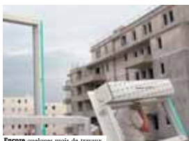
Encore quelques mois de travaux.
