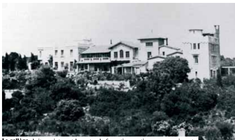
Le collège abrite maintenant le centre de formation continue pour enseignants.
