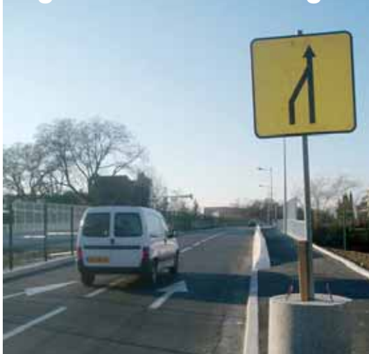
Le nouveau pont qui relie les avenues de la Liberté et Dubout a été ouvert à la circulation après un an de travaux de la 2 e ligne de tramway.
