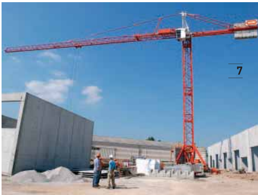
Le village d'entreprises Hannibal à Cournonsec.
