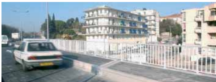
Le pont Dubout-Maurin rouvert aux voitures. Ici, la partie du pont qui enjambe l'avenue de Maurin.
