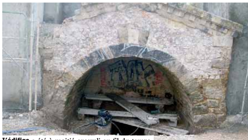
L'édifice a été à moitié enseveli au fil du temps.
