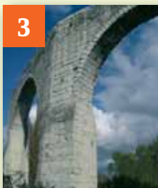
Angle de l'Aqueduc
