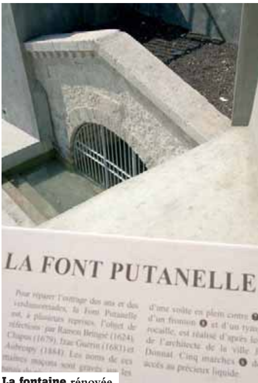
La fontaine rénovée.
