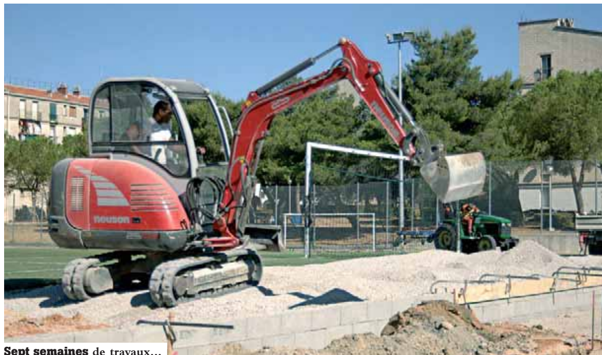
Sept semaines de travaux...
