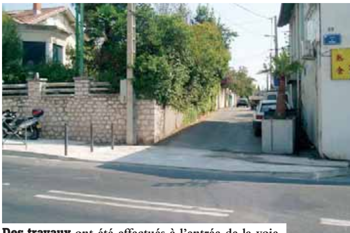
Des travaux ont été effectués à l'entrée de la voie.
