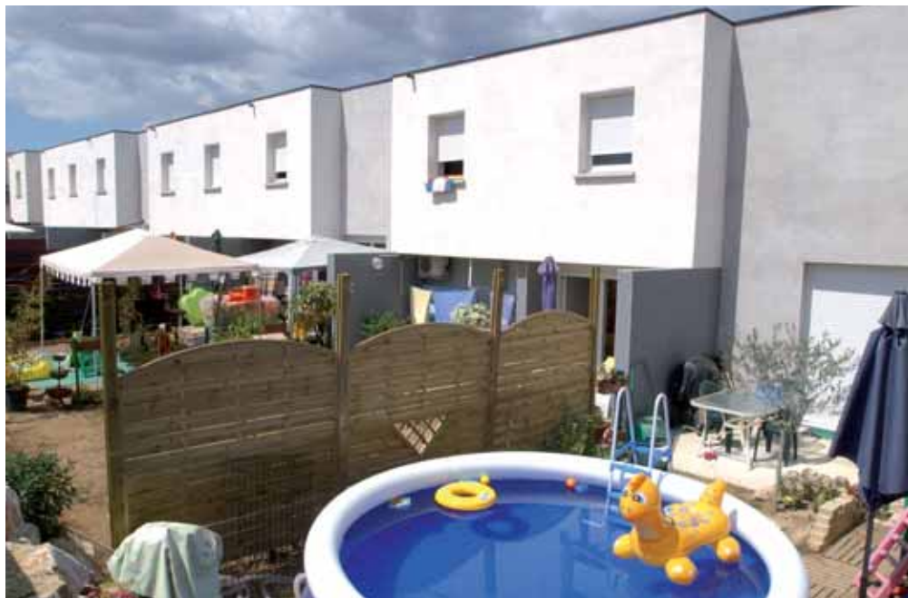
La résidence Le Casale à Malbosc, une maison à 100 000 euros en location-accession. Une réalisation soutenue par Montpellier Agglomération.
