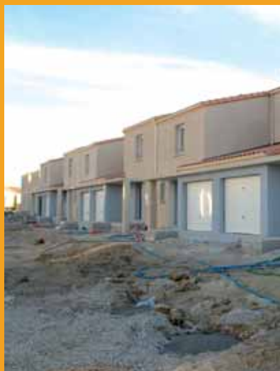
Le Rebayral à Saint Georges d'Orques en cours de construction.
