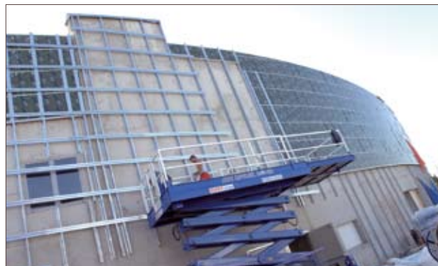
Mise en place d'un bardage en forme d'écailles.
