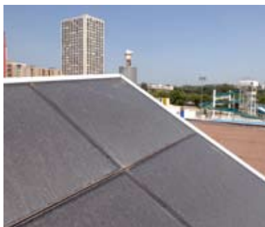
Des capteurs solaires thermiques chauffent les douches du centre nautique Neptune à la Mosson.
