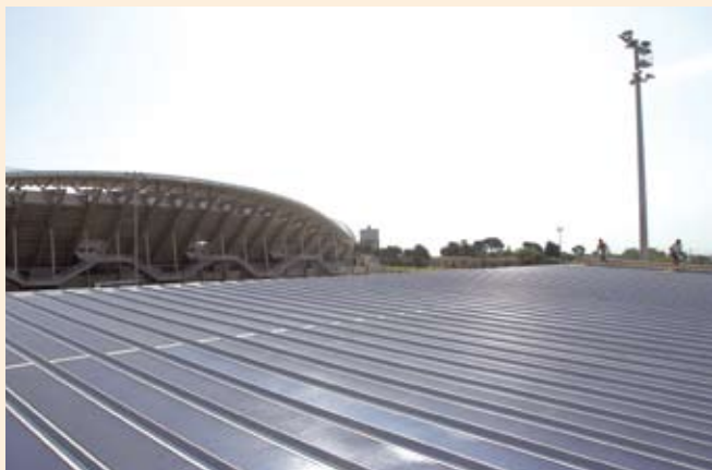
380m 2 de capteurs photovoltaïques et 9m 2 de capteurs solaires thermiques sont placés sur les bâtiments annexes du stade Yves du Manoir.
