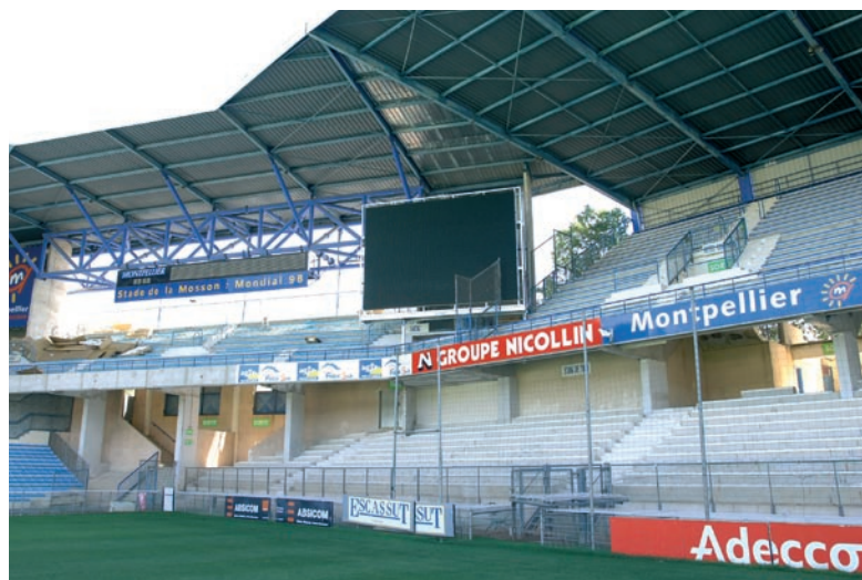
Mise en place de deux écrans géants.
