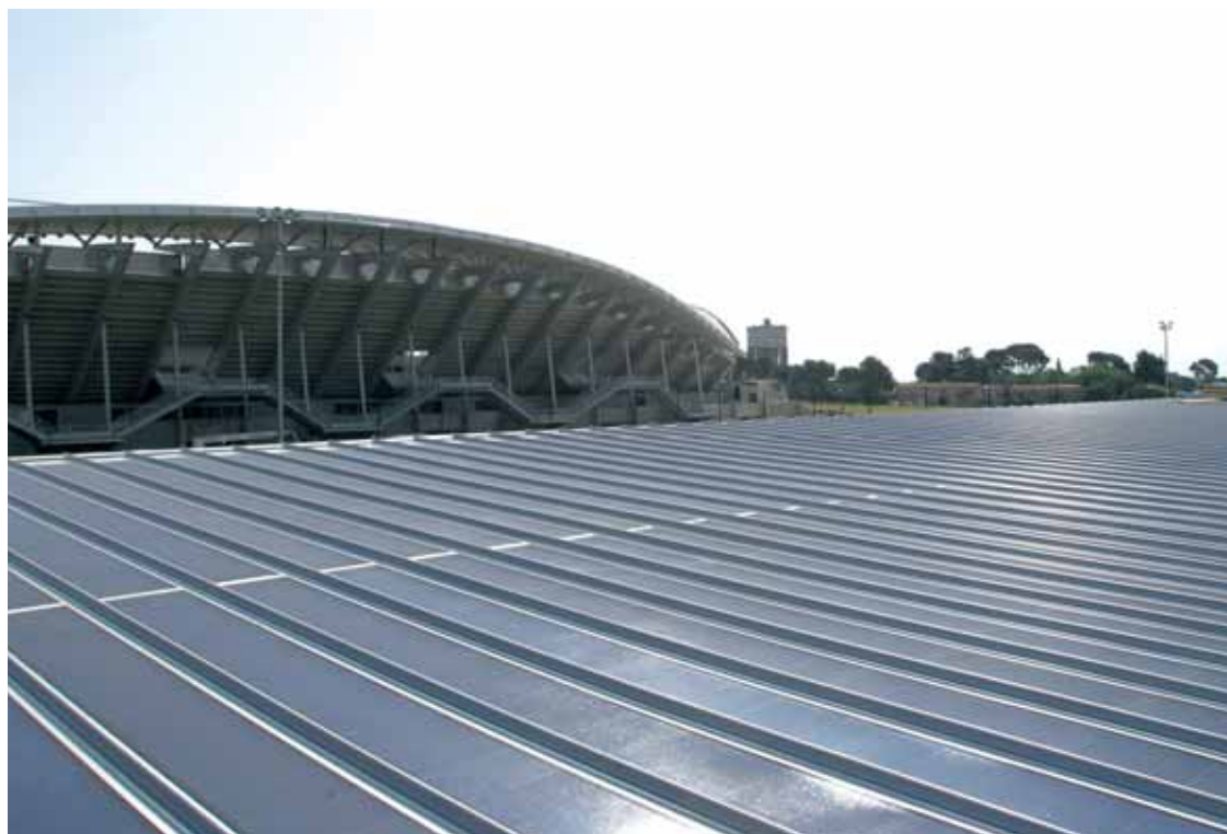
380 m 2 de capteurs photovoltaïques et 9 m 2 de capteurs solaires thermiques disposés sur les terrains annexes du stade Yves du Manoir produisent 36 100 kWh par an.
