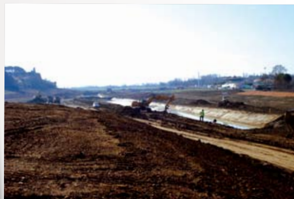
Atelier de terrassement en grande masse : Rendement : 3 500m 3 de terre par jour
