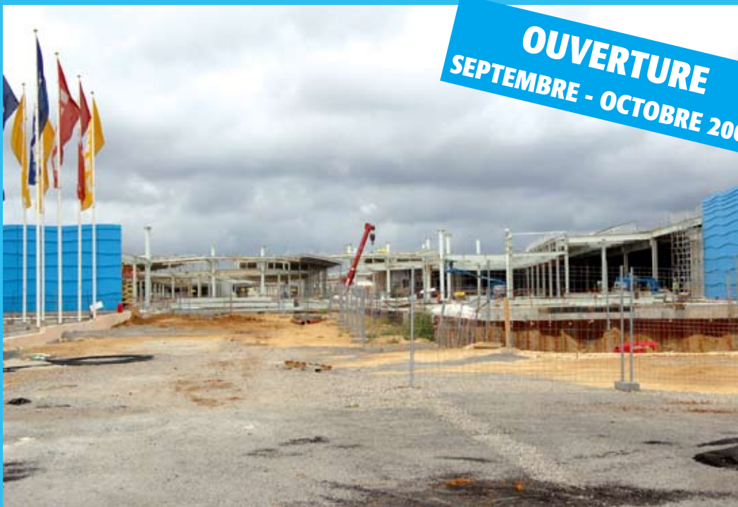
Vue du côté Est, entre IKEA et Décathlon, sur la droite du chantier, le futur hypermarché Géant Casino et au centre le complexe commercial.
