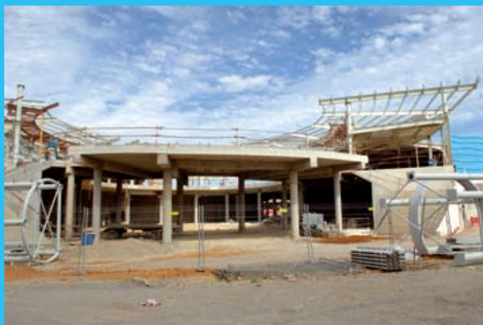
Vue du côté Ouest, à l'extrémité du bowlingstar et Kartingstar, se dessine la forme circulaire de l'entrée du bâtiment.
