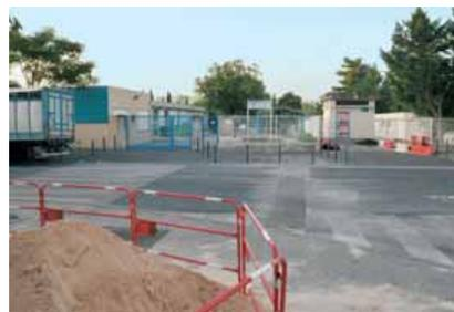
Un plateau surélevé, de couleur claire, long de 35 m, est créé au niveau des deux sorties d'écoles, afin de sécuriser la traversée des enfants. Un garde-corps servant à canaliser les piétons est également mis en place. Le trottoir situé le long du bouledrome est élargi à 2,2 m pour plus de confort. Enfin, les carrefours avec les rues de Lausanne et de la Haye sont resserrés dans le but de faire ralentir les automobilistes.
