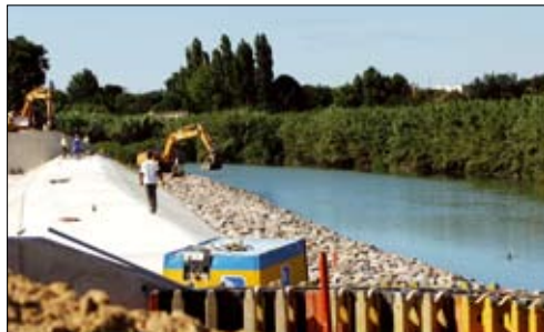
Déversoir de la Lironde
