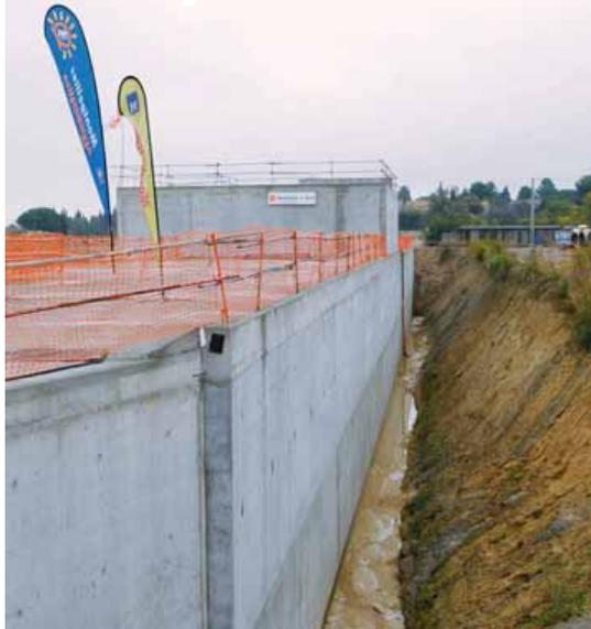
**Le bassin d'orage** des Aiguerelles est achevé. D'une capacité de 20 000 m<sup>3</sup>, il récupère les eaux de pluies et évite leur déversement dans le Lez.
