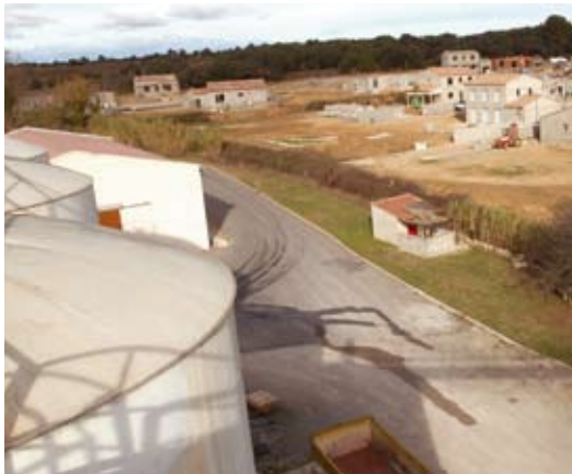
Cuves, habitation, bureaux, hangars sur une même parcelle.
