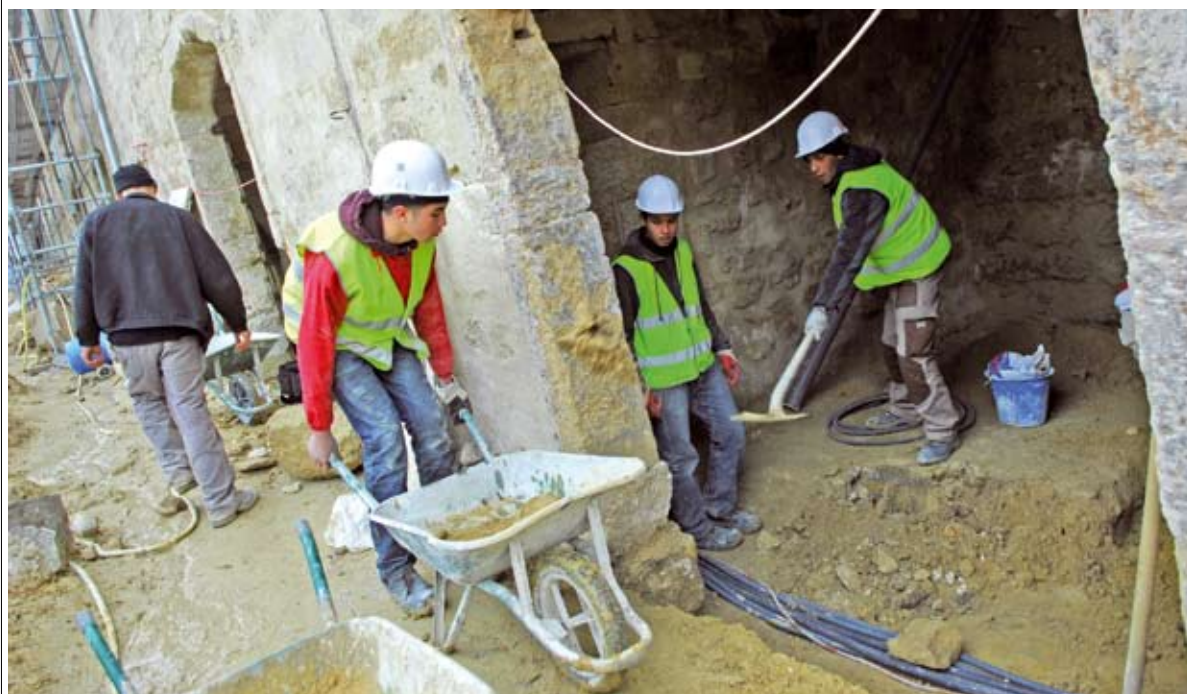
Sur le chantier de la Maison des Métiers d'Arts, les sols sont nivelés avant de couler la dalle : du très gros œuvre.
