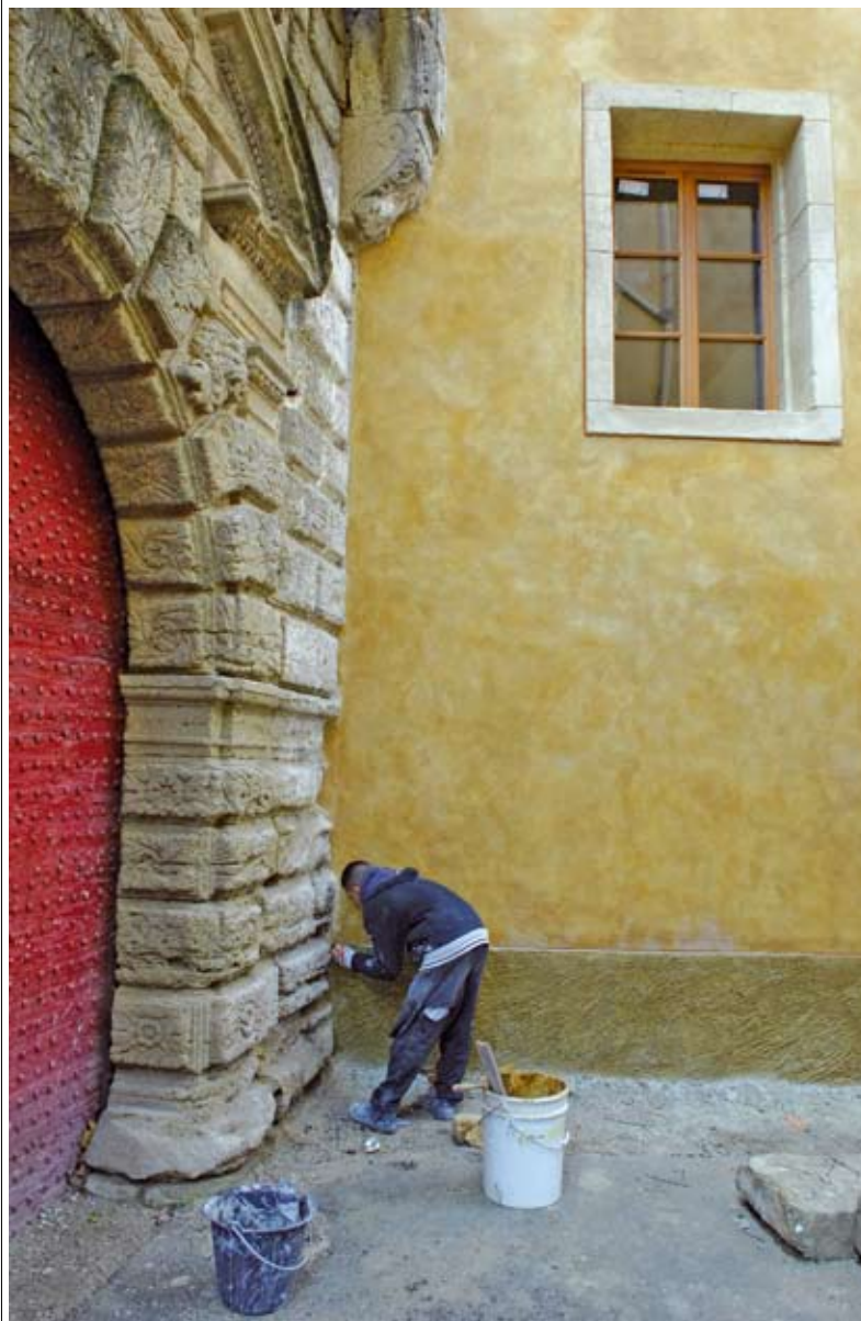
Adossée au mur du château de Lavérune, la maison du gardien a été rénovée selon des techniques ancestrales.
