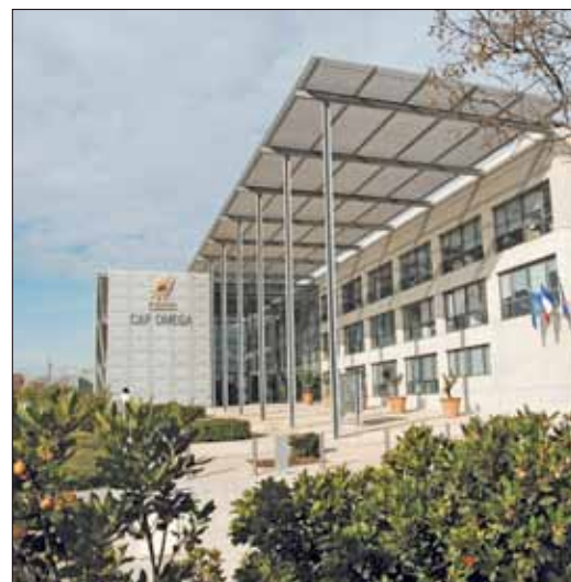
Cap Omega, une des deux pépinières d'entreprises de Montpellier Agglomération.
