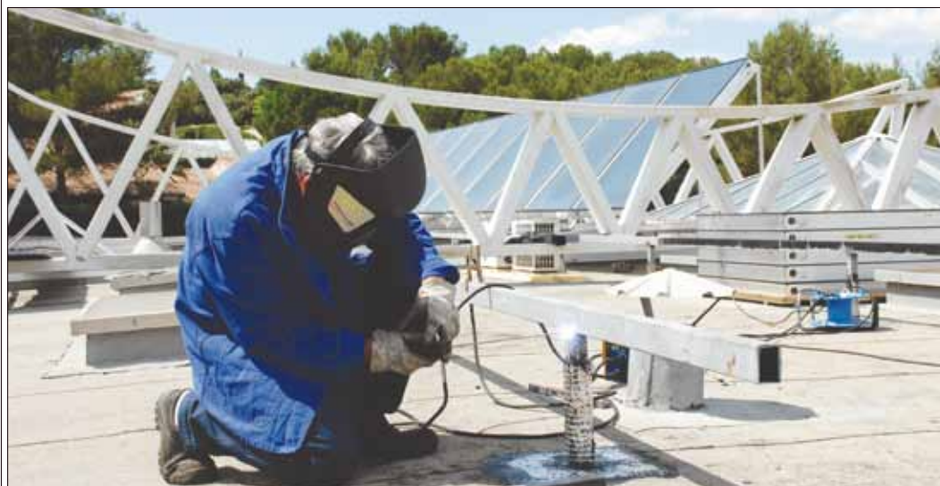
Montpellier Agglomération montre l'exemple en installant des panneaux solaires sur ses bâtiments.
