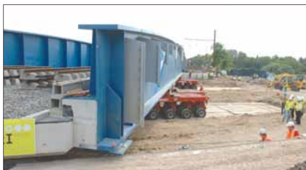
Le 23 mai, le ripage du nouveau pont de 1 600 tonnes s'est déroulé en moins de 4 heures. Coût de l'opération intégralement financée par Montpellier Agglomération : 5,7 millions d'euros.
