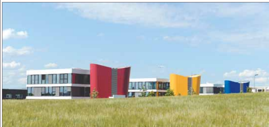
Le parc d'activités de l'Aéroport de Montpellier Agglomération, idéalement situé près de l'aéroport Montpellier Méditerranée et de l'A9, séduit les entreprises. La quasi-totalité des parcelles est occupée ou réservée.
