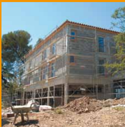
Logements sociaux en construction à Cournonsec
