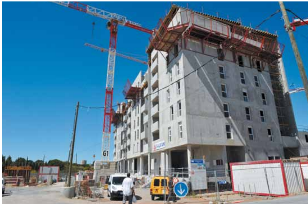
Zac Consuls de Mer, 45 logements sociaux ACM en construction.
