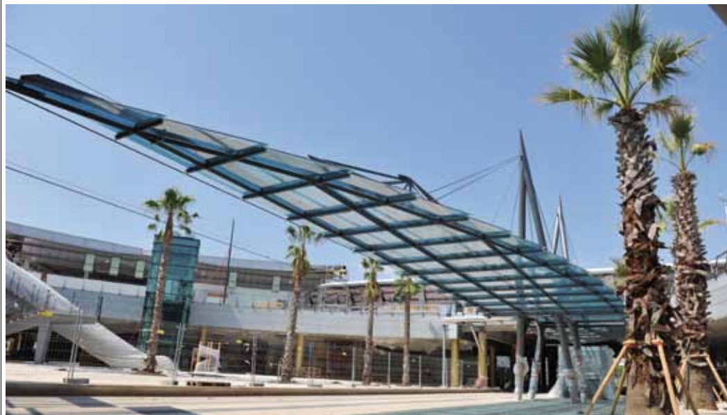
La nouvelle station de tramway « Odysseum » en plein cœur du centre commercial.
