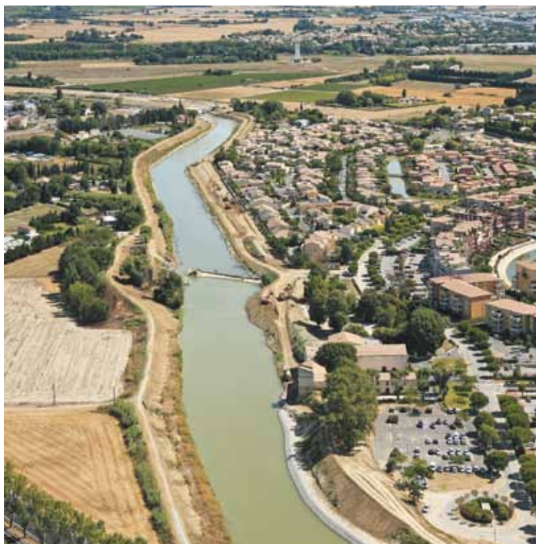
Une vue d'ensemble des digues du Lez, confortées en priorité sur les quartiers très urbains.
