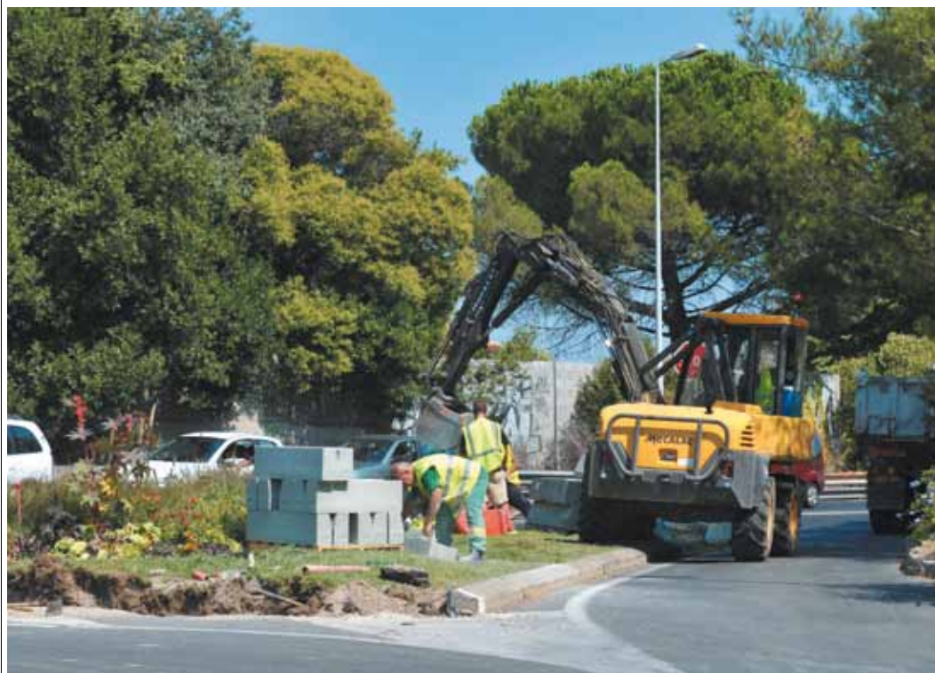
Cours de la Liberté à Montpellier, les travaux préparatoires permettent de libérer l'emprise nécessaire à la construction de la plate-forme de tramway.
