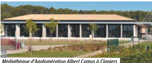
Médiathèque d'Agglomération Albert Camus à Clapiers
