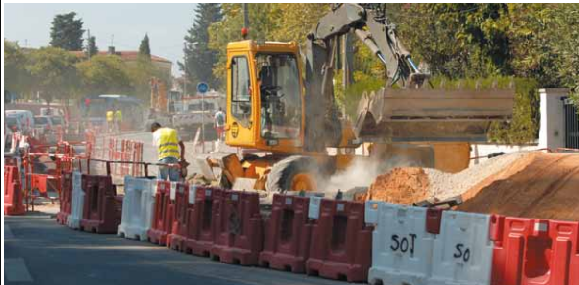
Travaux préparatoires sur le tracé de la ligne 3 qui mènera de Juvignac à Pérols.
