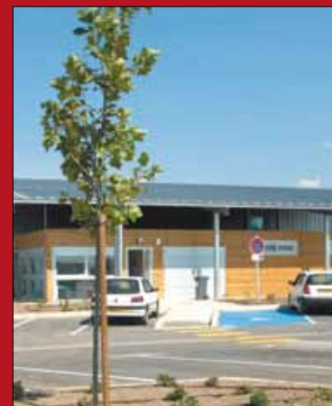
À Pignan un toit de panneaux photovoltaïques.
