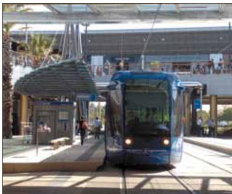
Le tramway de Montpellier Agglomération constitue le lien entre deux quartiers de Montpellier : Odysseum et le centre-ville.
