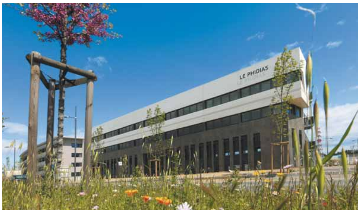
L'immeuble de bureaux le Phidias, sur le parc Eurêka.
