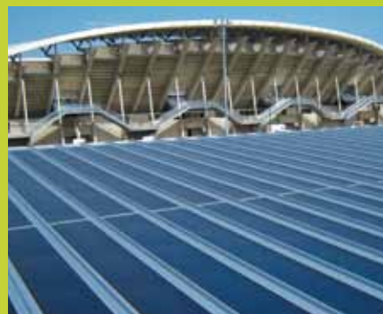
Le stade Yves du Manoir de Montpellier Agglomération produit 28 600 kWh/an grâce à ses 380 m 2 de panneaux photovoltaïques.
