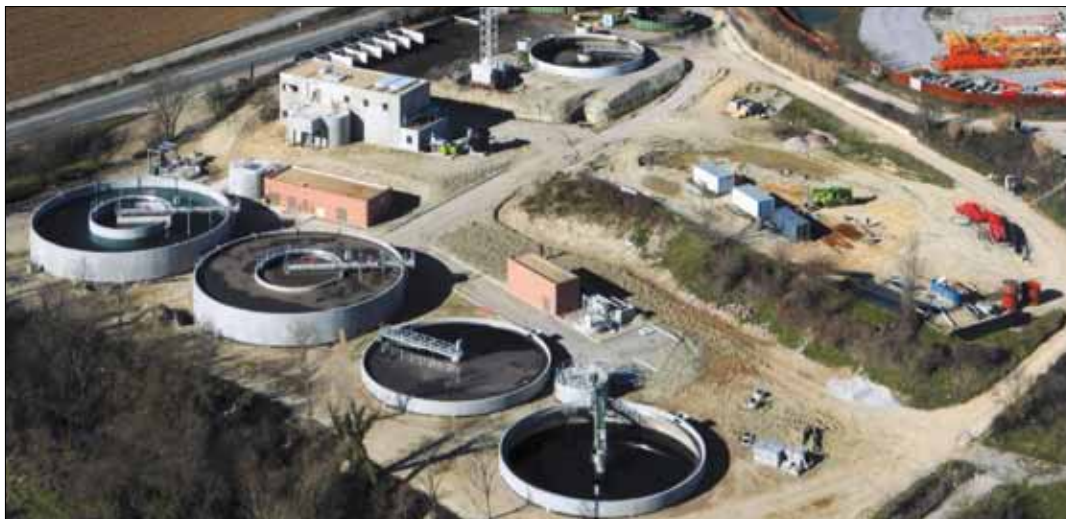
Le traitement des eaux usées et des boues de Pignan, Saussan et Fabrègues a démarré. La station intercommunale sera totalement achevée en septembre.
