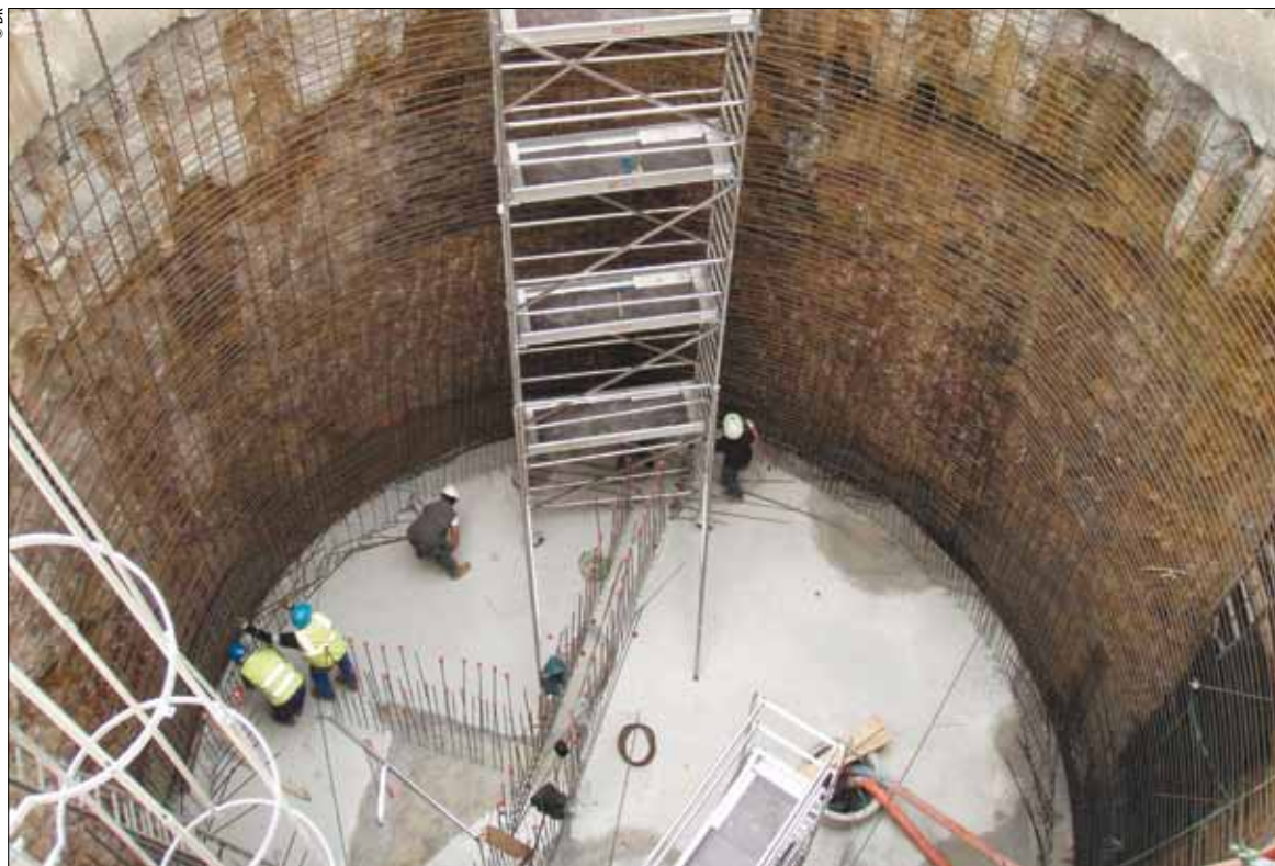
Deux postes de refoulement, dont un de plus de 16 m de profondeur et 9 m de diamètre (photo), ont été construits en sous-sol à Vendargues pour acheminer les eaux usées de six nouvelles communes vers la station d'épuration Maera.
