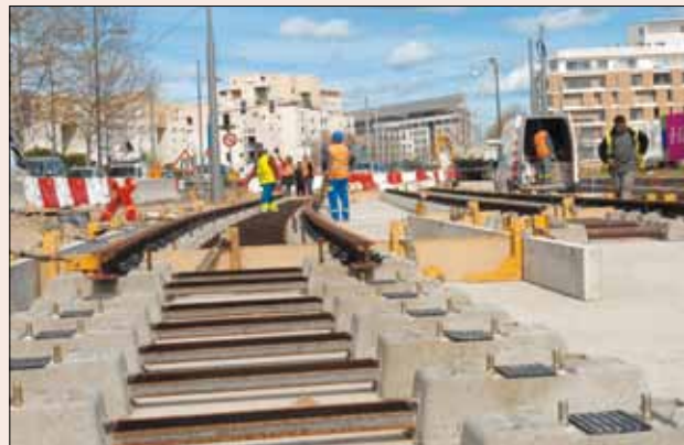
Les premiers rails ont été posés sur l'avenue Antonelli dans le quartier Port Marianne et au rond-point des Prés d'Arènes. Suivront dès mi-mai le rond-point Ernest Granier, puis le pôle Mosson, rue d'Alco, avenue de Lodève, Bringuier, Gambetta, avenue des Prés d'Arènes... Fin 2010, 50 % des rails seront posés.
