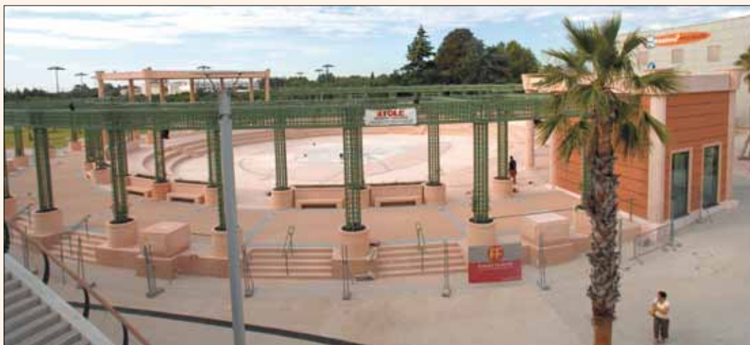
Derniers travaux du théâtre Helios et de la place du XX e siècle avant leur inauguration. Un espace ludique de détente et de spectacle qui devrait être bien populaire.
