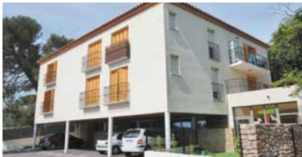
En juin, six nouveaux logements sociaux et une crèche associative ont été construits par ACM à Courmoussac.
