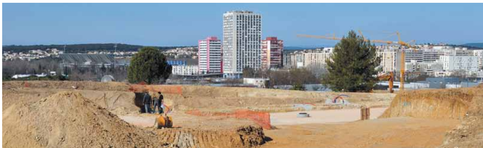
Sept sièges d'entreprises et un hôtel d'entreprises sont déjà en cours de construction sur la première extension de Parc 2000.
