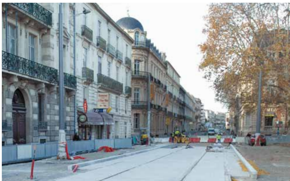
Rue de la République, devant la Gare Saint-Roch, centre névralgique du réseau des transports de Montpellier Agglomération, les quais de la future station des lignes 3 et 4 prennent forme.
