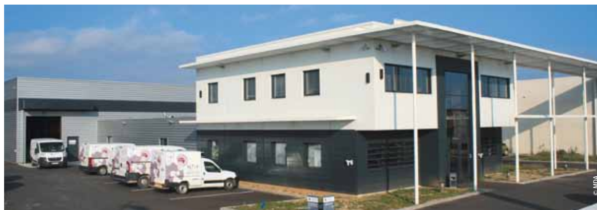
Sur le parc d'activités de l'Aéroport, très demandé, MDA, installateur de distributeurs automatiques, a construit un entrepôt et des bureaux.
