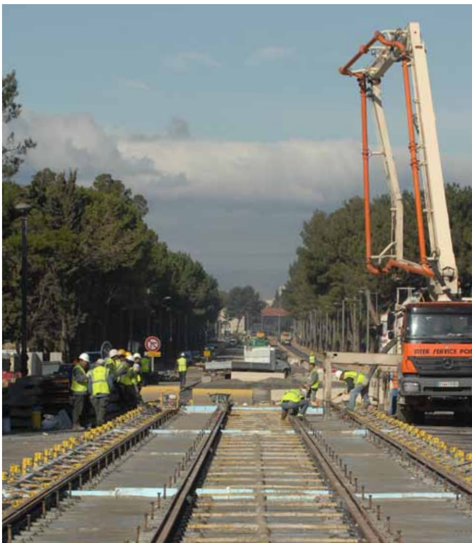
A Lattes, les rails sont posés le long de l'avenue Georges Frêche.
