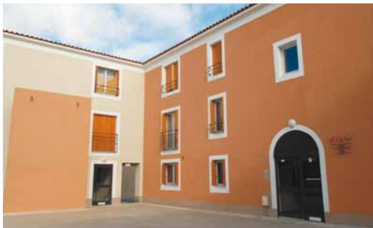
Logements sociaux à Pignan.
