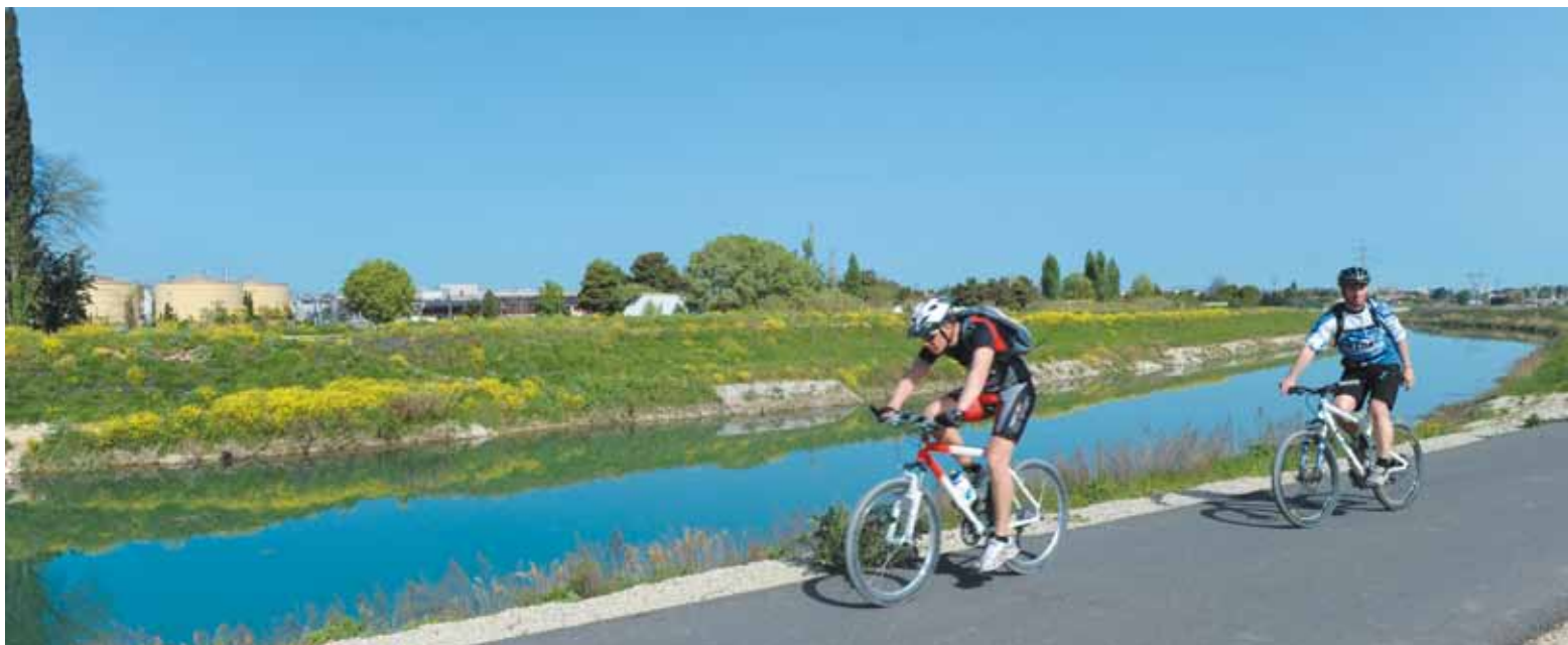
Montpellier Agglomération a aménagé une large piste cyclable au sommet de la digue entre Montpellier et Lattes. À l'arrière-plan, la station d'épuration Maera construite en 2006, qui a permis d'améliorer considérablement la qualité de l'eau du Lez.
