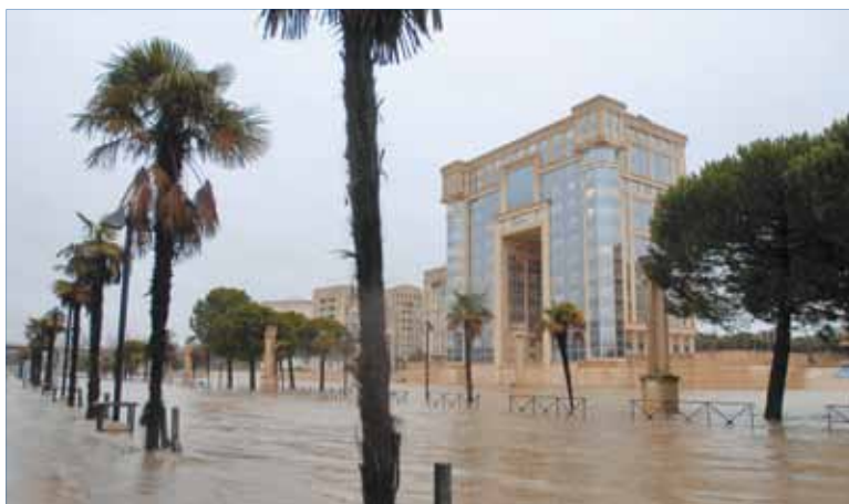
Les berges ont été aménagées de façon à laisser le Lez monter pendant les fortes pluies, comme ici, en février 2009.
