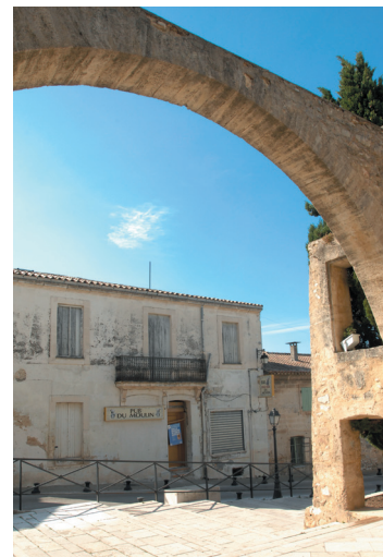
Au centre de Castries, cet ancien bâtiment sera réhabilité pour créer un logement loué à loyer maîtrisé.
