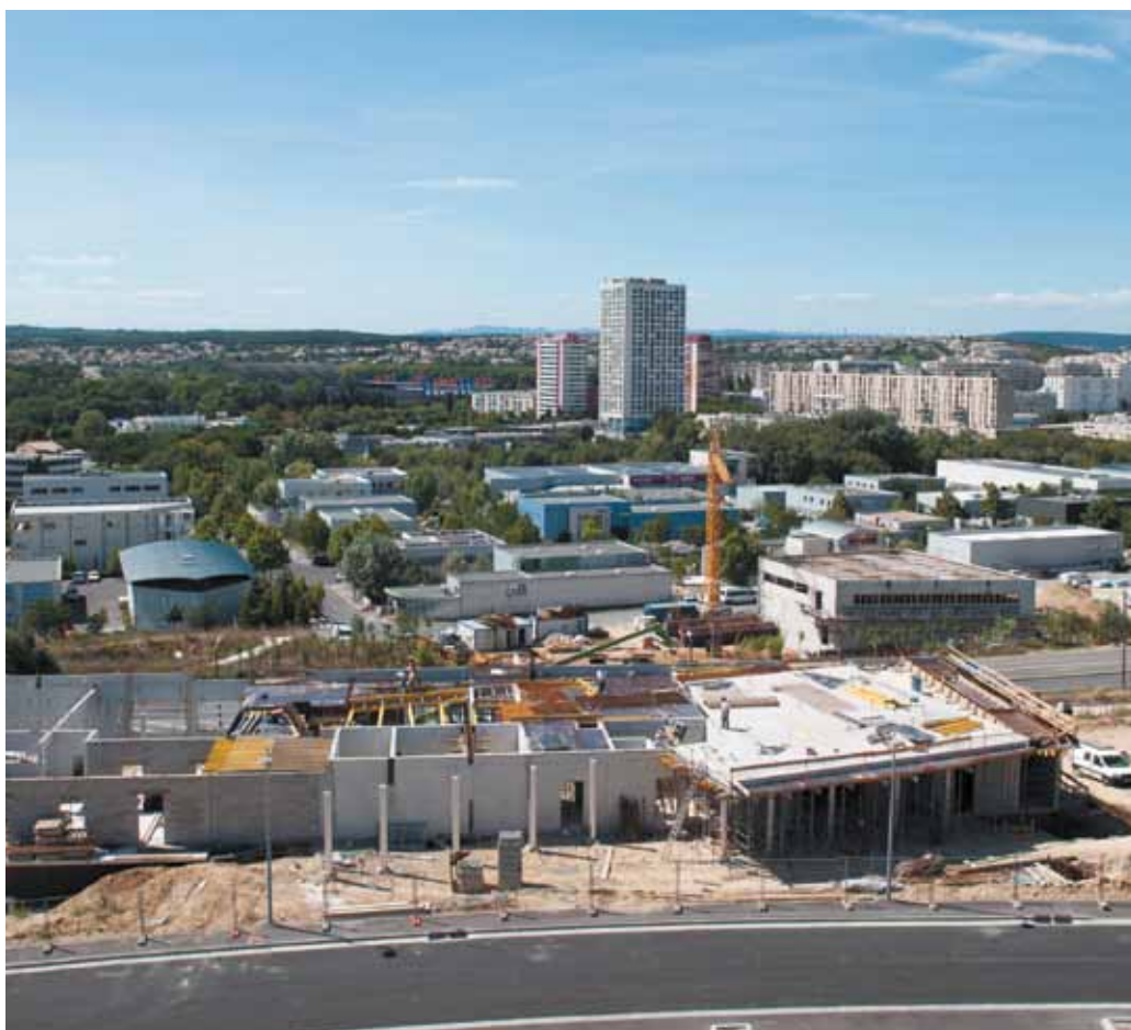
Construction de nouveaux locaux d'entreprises sur Parc 2000, dans le quartier de la Mosson.
