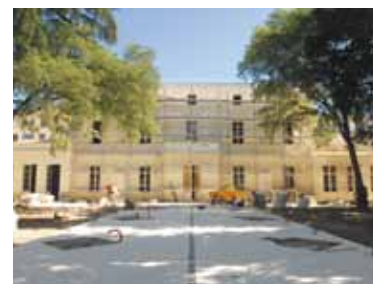
Un millier d'objets seront mis en valeur dans ce futur musée de l'histoire de France en Algérie en cours de construction.
