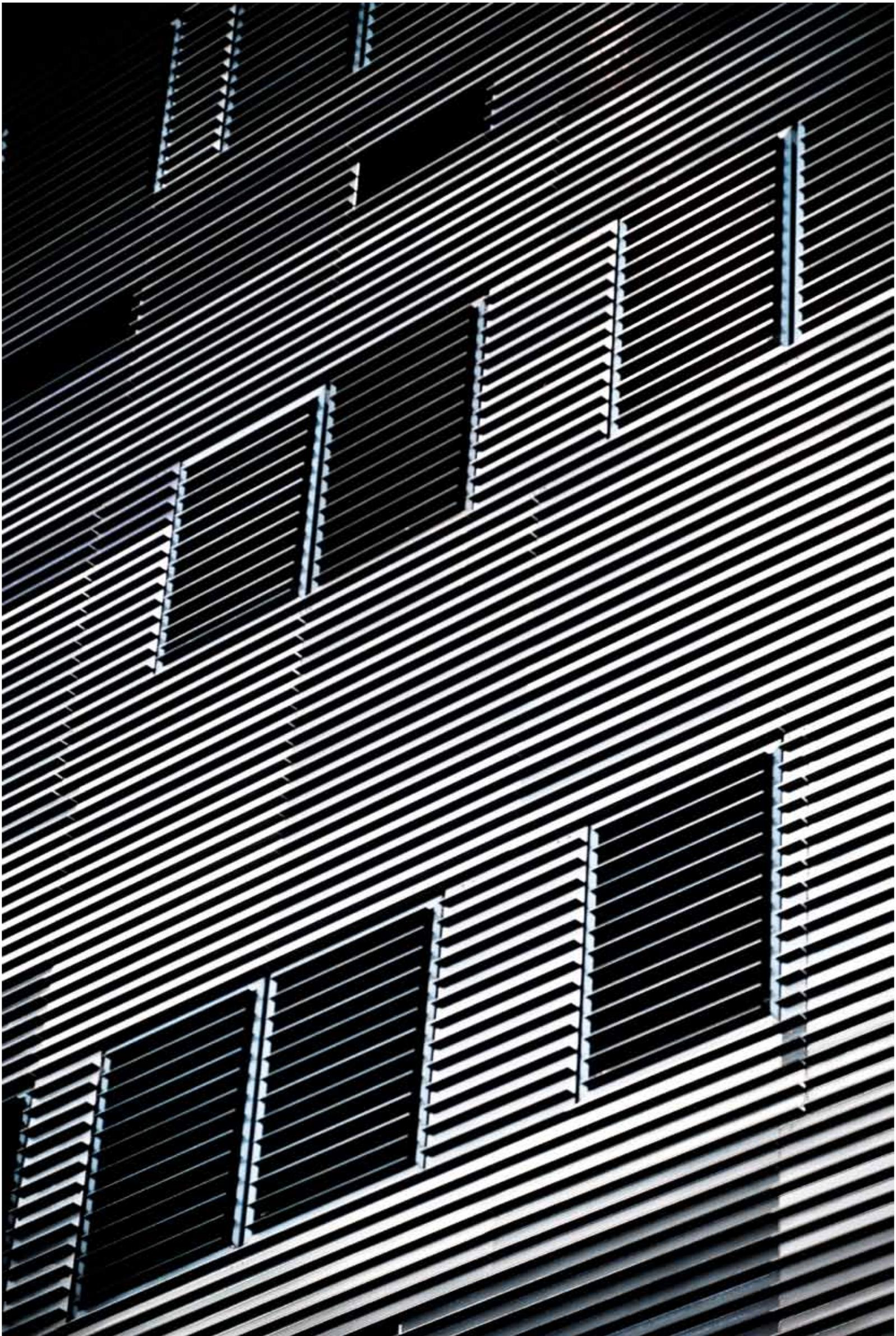
**Architecture.** Côté Sud-Est, un système de stores inclinables sur les fenêtres s'intègre parfaitement à la façade. Il fait partie des nombreuses innovations techniques permettant de favoriser l'inertie thermique du bâtiment.
