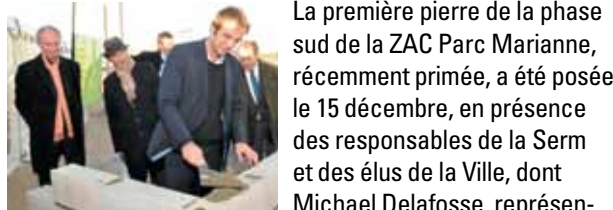
La première pierre de la phase sud de la ZAC Parc Marianne, récemment primée, a été posée le 15 décembre, en présence des responsables de la Serm et des élus de la Ville, dont Michael Delafosse, représentant le maire. Cette nouvelle tranche de la ZAC accueillera 800 logements supplémentaires à terme.
