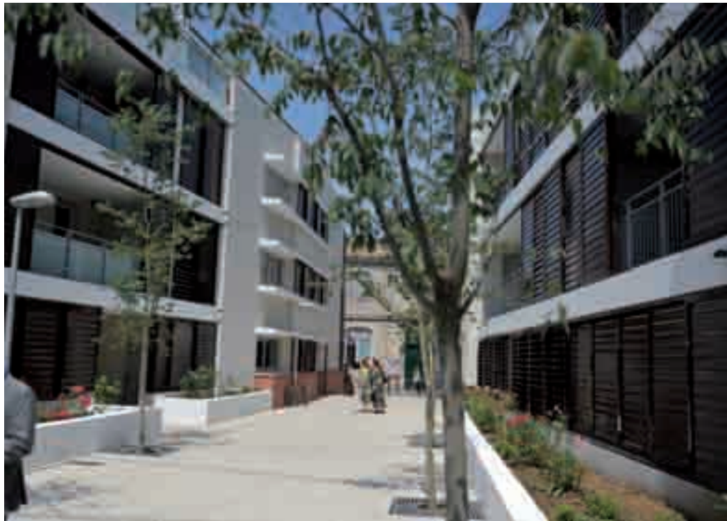
Le Maguelone, une résidence de 39 logements locatifs sociaux située rue Chaptal.
