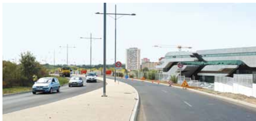
Montpellier consacre 2,1 millions d'euros pour le réaménagement de la rue du Professeur-Blayac et de l'avenue de l'Europe.
