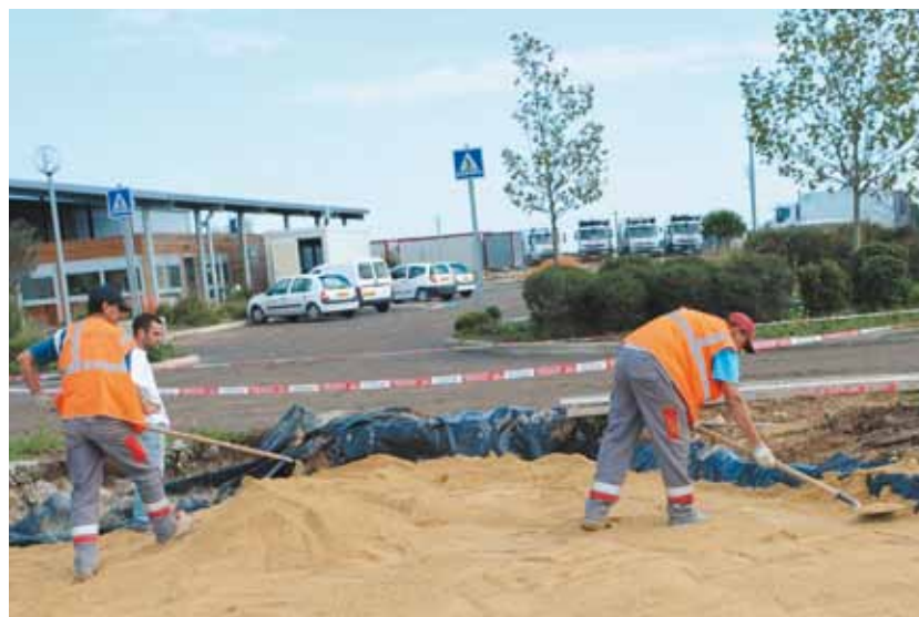
Les travaux d'extension du pôle d'exploitation de Pignan se termineront à la fin de l'année et permettront d'améliorer la qualité de la collecte des déchets.
