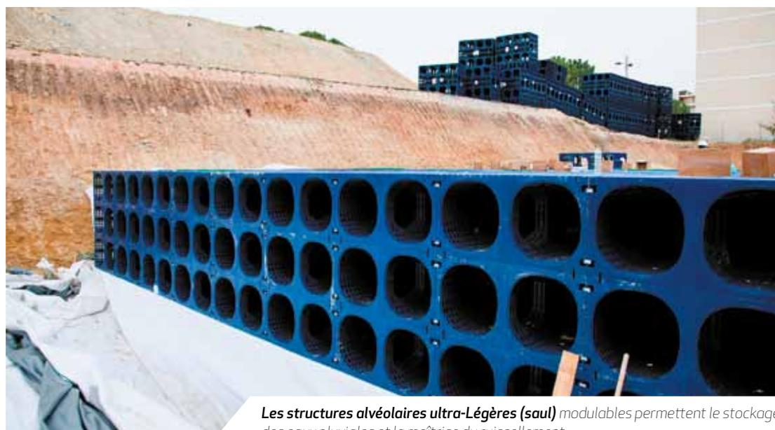
Les structures alvéolaires ultra-Légères (saul) modulables permettent le stockage des eaux pluviales et la maîtrise du ruissellement.
