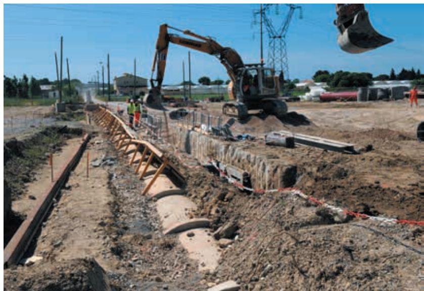
À Lattes, les conduites d'eau potable et d'eaux usées, gérées par l'Agglomération, sont déplacées avant le chantier de l'A9.
