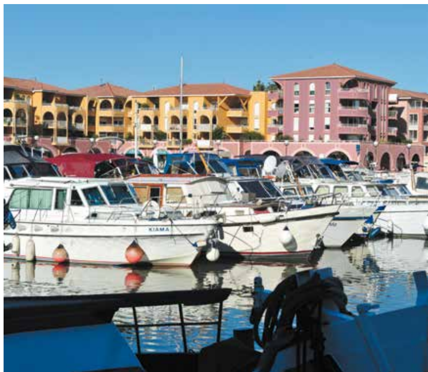
Port Ariane, construit dans les années 90, renoue avec la tradition portuaire de Lattes, très
