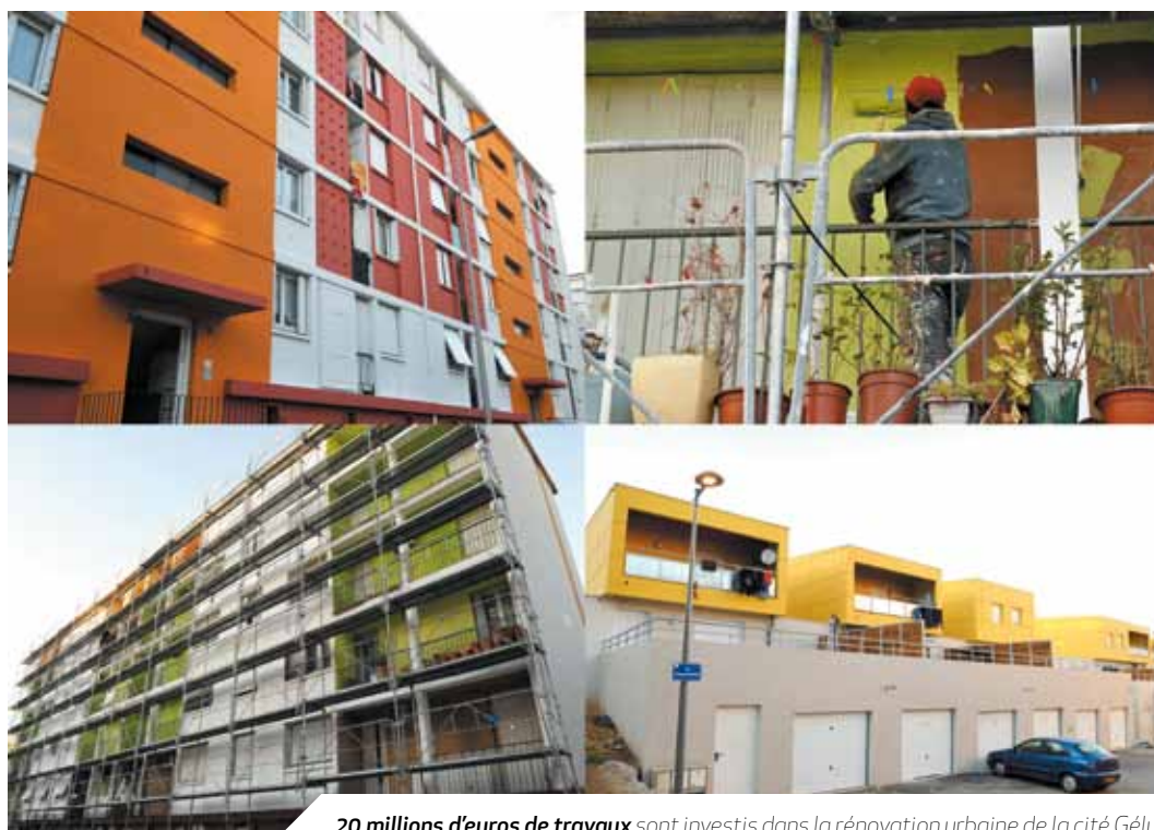
20 millions d'euros de travaux sont investis dans la rénovation urbaine de la cité Gély.
